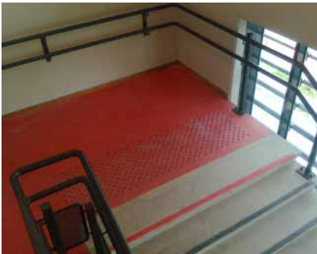
Mains courantes continues sur le palier (idéalement contrastées) permettant aux PMR de maintenir leur appui
