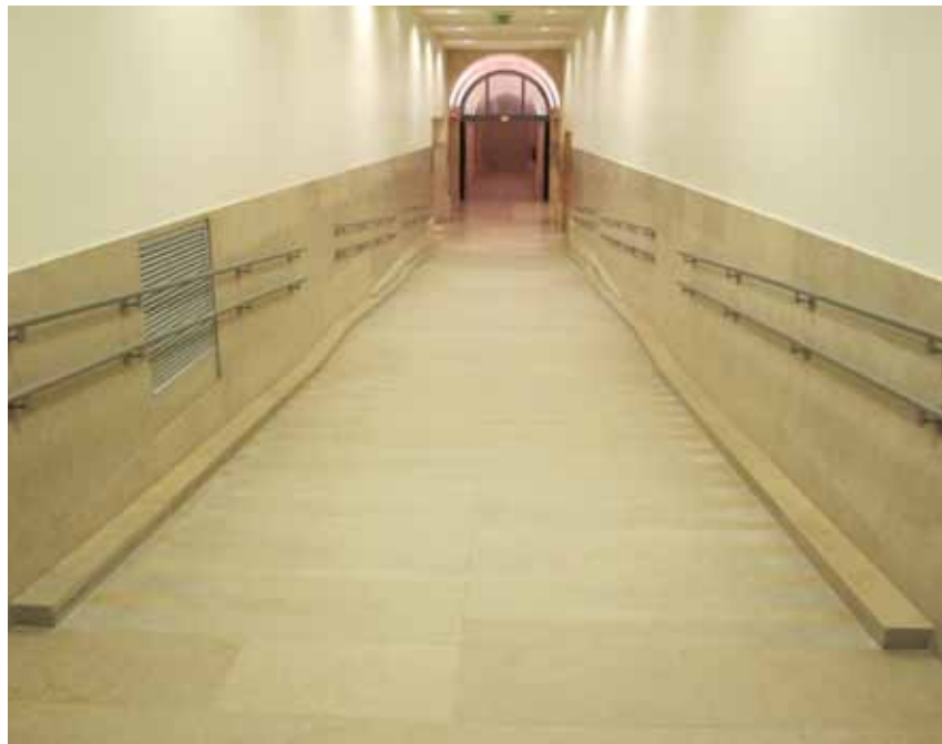
Couloir de circulation confortable pour tous : pente douce avec paliers de repos, passage large et dégagé, double main courante, éclairage de qualité
